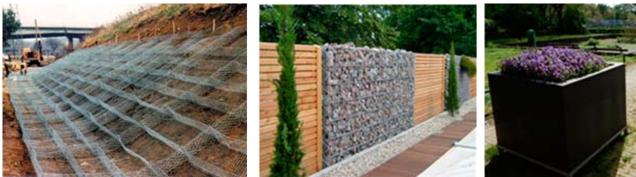
а б в Рис. 1. Использование в благоустройстве легкозаменяемых элементов. Возможность применения ручного труда: а – склоны с устройством габионов и матрасов Рено; б – секционные ограждения из габионов; в – легкие унифицированные кашпо. Фото Л.В. Анисимовой
