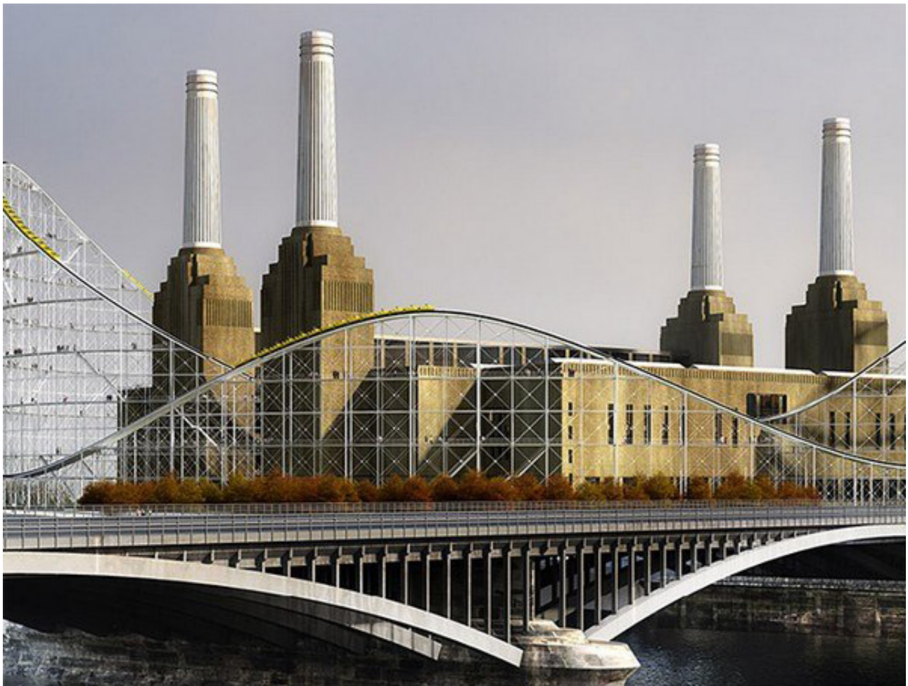
Рис. 2. Электростанция в Баттерси. Лондон. 1930-е гг. Источник: http://vk.com/wall-35532962_2112
