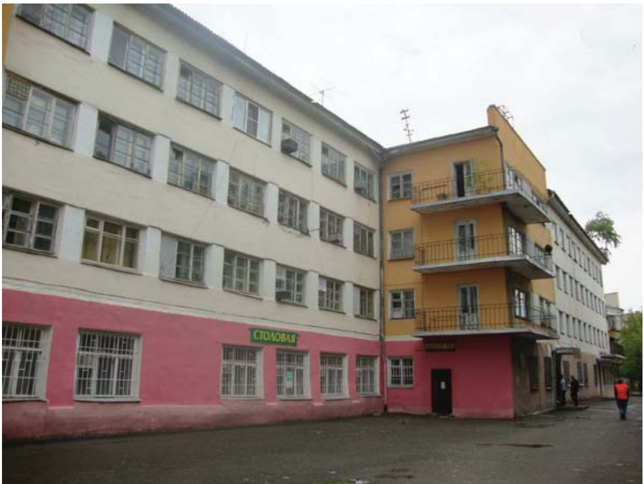
Рис. 2. Здание гостиницы для ИТР, 1932-1935 гг., ул. К. Маркса, 83. Фото С.И. Гавриловой
