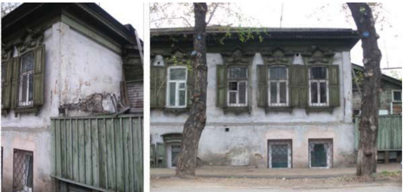
Рис. 14. Пример деревянного оштукатуренного дома с подшивным дощатым фризом. На боковом фасаде видна драпка деревянной стены (ул. Некрасова 9а). Фото М. Мееровича
