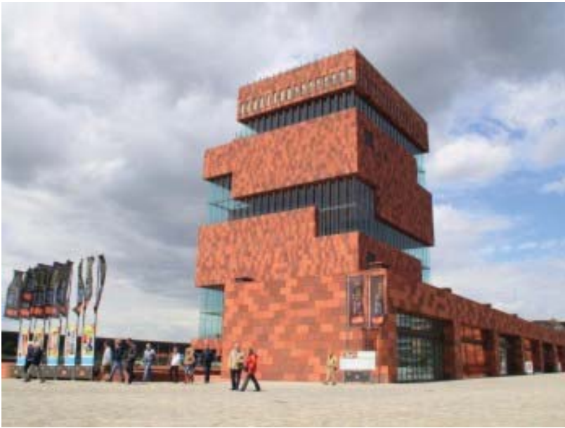
Рис. 9. Краеведческий музей в Антверпене. Арх. Я. Нойтелингс и М. Ридайк, 2011. Внешняя произвольная оболочка здания, никак не связанная с его каркасом, нарушает традиционную тектоническую логику, основанную на телесности массы. Масштабные ощущения полностью игнорируются. Источник: http://euro-puls.ru/articles/2011-07-18-11-51-18-2028-mas
